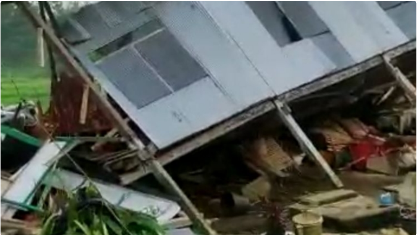
17 rumah rusak parah akibat angin puting beliung di Desa Pancana, Kecamatan Tanete Rilau, kabupaten Barru
