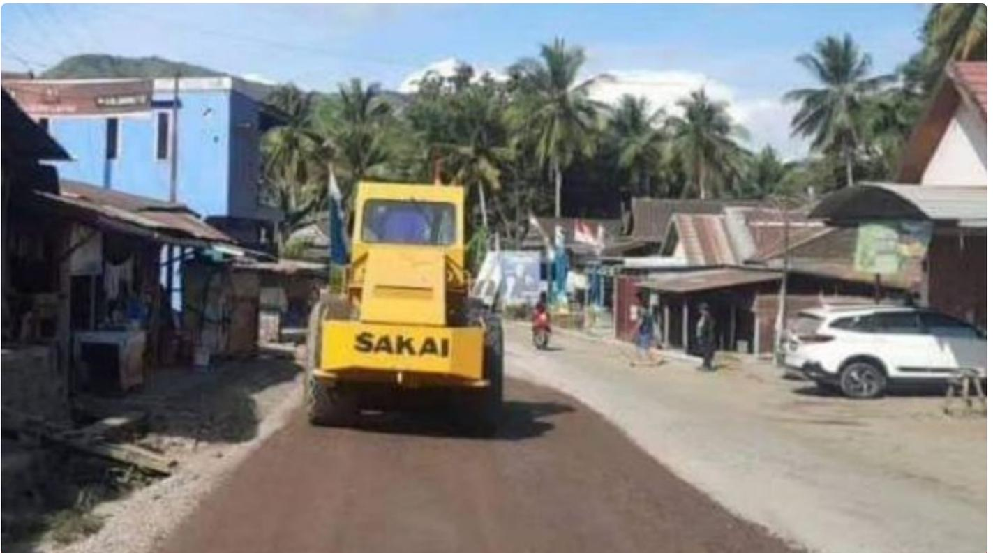
*progres pemadatan LPA dan Agregat kelas untuk paket Long Segment progres penanganan reconstruksi sedang berjalan di Batas Soppeng - Barru*
